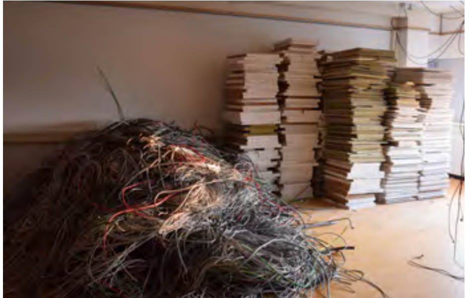
Sorteren van plafondplaten en kabels
