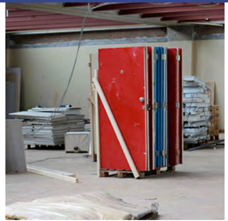
Deuren staan gereed voor opslag.
