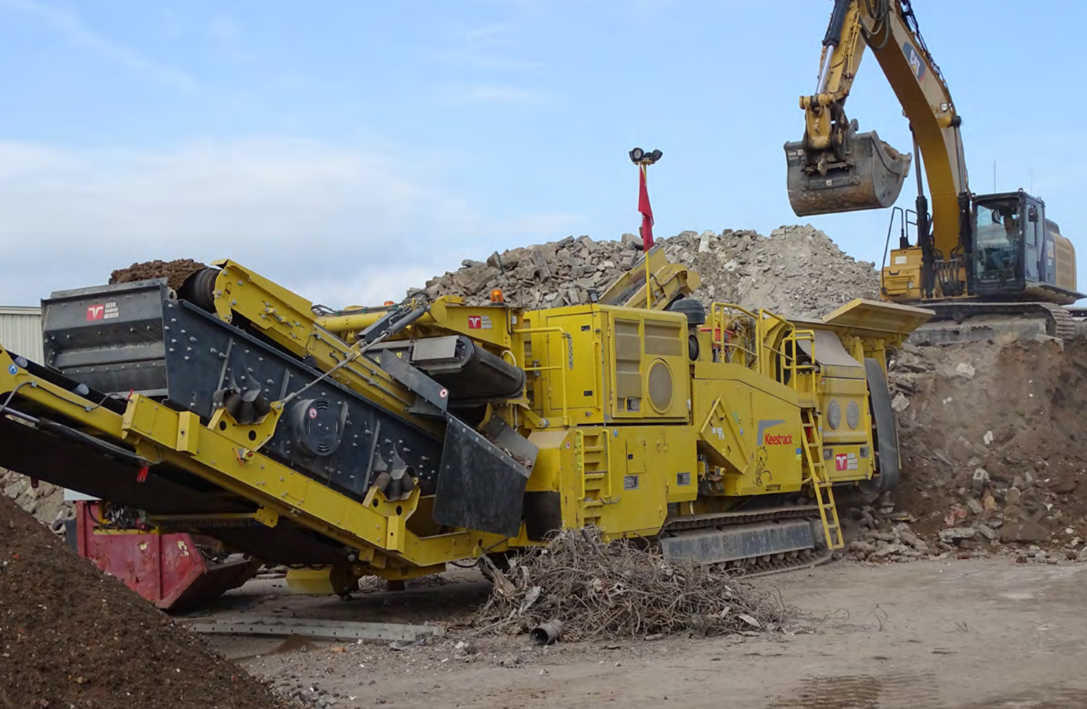
Begin 2018 werd een elektrisch aangedreven KeestrackE5 puinbreker in bedrijf genomen.
